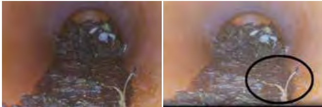
Imagen de una tubería durante la inspección.
