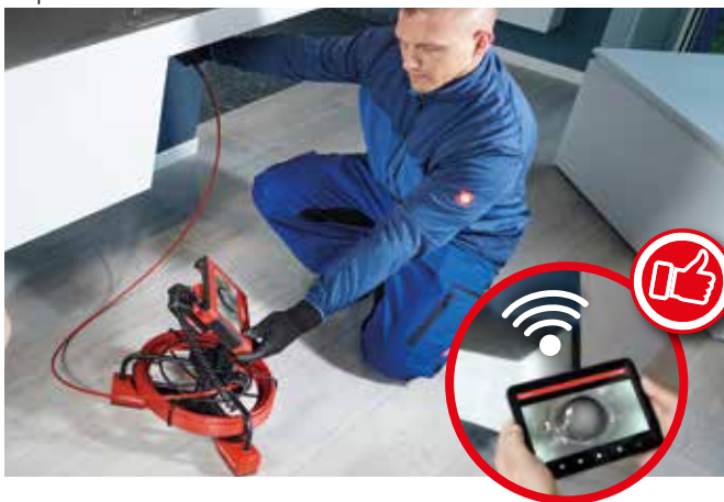
Inspección con ROCAM MINI HD con módulo 25/22 HD.
