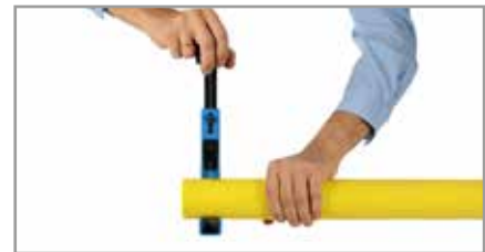
3. Cortar el tubo de forma totalmente recta.
