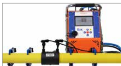
11. Inicio de la soldadura.
