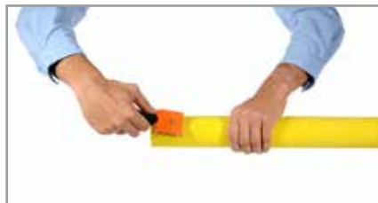
5. Rasar la zona de soldadura del tubo.
