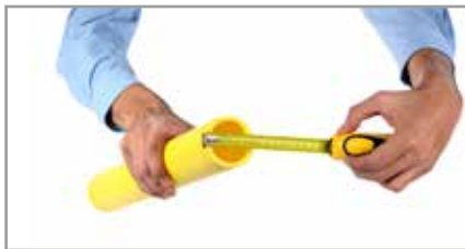
1. Medir el diámetro del tubo.
