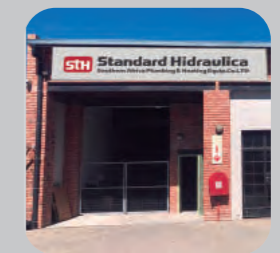
Sudáfrica (Ciudad del Cabo) Superficie 300 m2 Facilities / Installations
