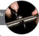
Embutir el extremo del tubo con el pistón
