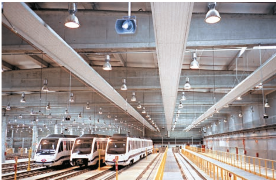
Instalación de calefacción con paneles radiantes SABIANA en el metro de Madrid.
