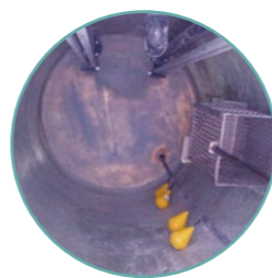
pozos de bombeo
