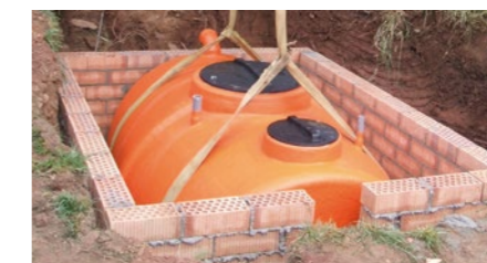
NECOR 5 vivienda unifamiliar
