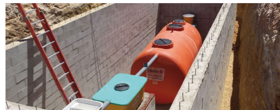
Instalación depuradora perfil hidráulico
