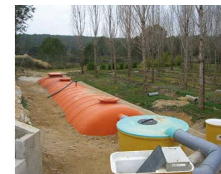
Instalación depuradora perfil hidráulico
